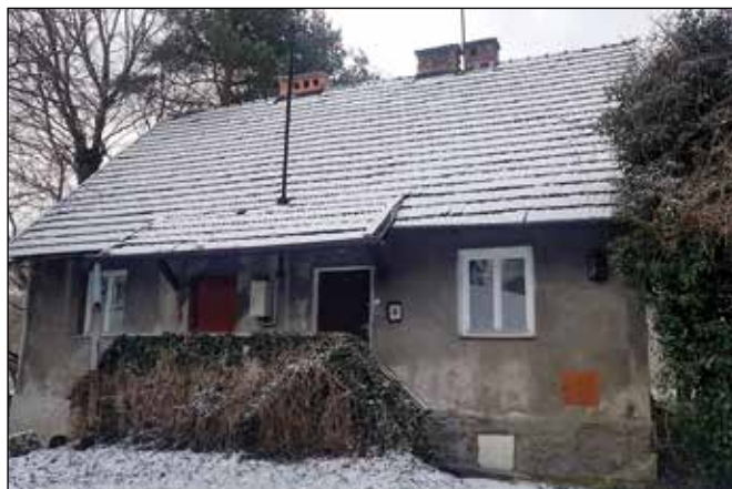
Casa de Polonia antes de la rehabilitación
